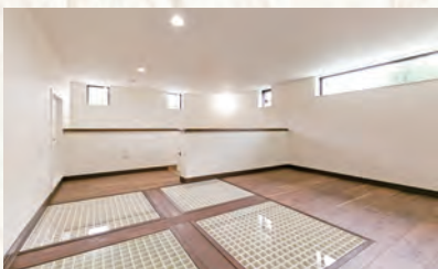
自然落雪屋根を利用したロフトです。2階へ通風・採光のために秘密の仕掛けがあります。
