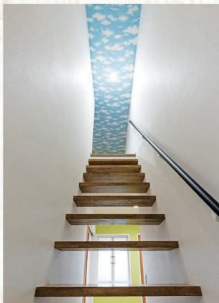
スケルトン鉄骨階段。視界の広がり、と通風、採光を考慮しています。
